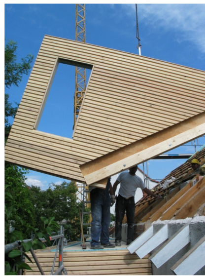
Der Anbau im Norden – hochgedämmte Wohnraum-Erweiterung in vorgefertigtem Holzrahmen- Bau.
