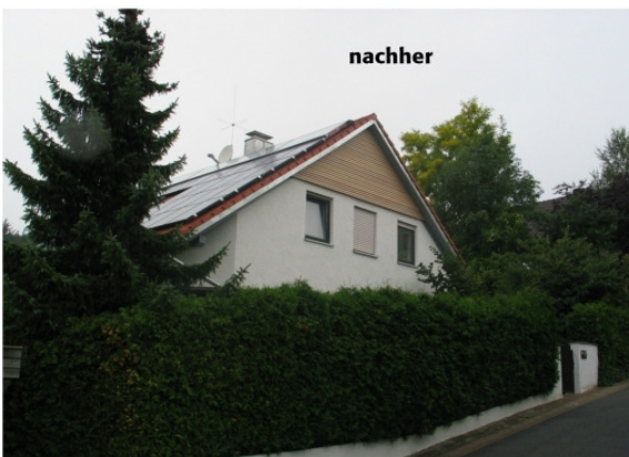
Durch die neue Dachform, die Verschalung im Giebel und die beiden Solaranlagen bekommt das Haus eine moderne Optik.
