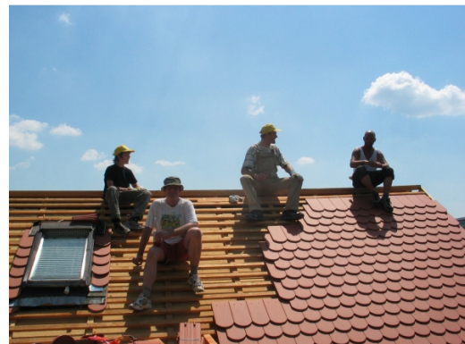
Dacheindeckung in Bieberschwanz - bei schönem Wetter und mit genug Helfern im Sommer eine Sache von einem Tag Arbeit
