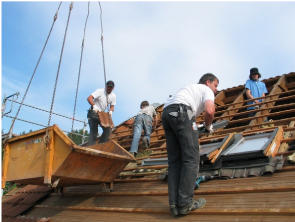
Das alte Dach wurde vollständig ausgedeckt. Die Dachflächenfenster konnten bleiben – sie wurden vor Abschluss der Arbeiten wieder eingesetzt.
