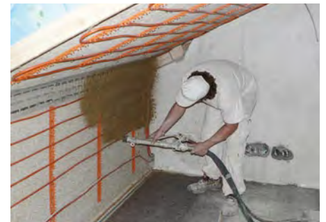
Lehm reguliert die Raumfeuchte, gibt Speichermasse für Behaglichkeit im Winter und besonders guten sommerlichen Wärmeschutz.
