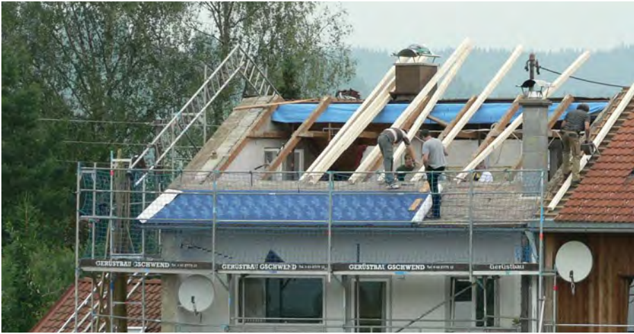
Das alte Sparrendach wurde für die Gaube mit einer Pfette und Aufdoppelungen verstärkt.
