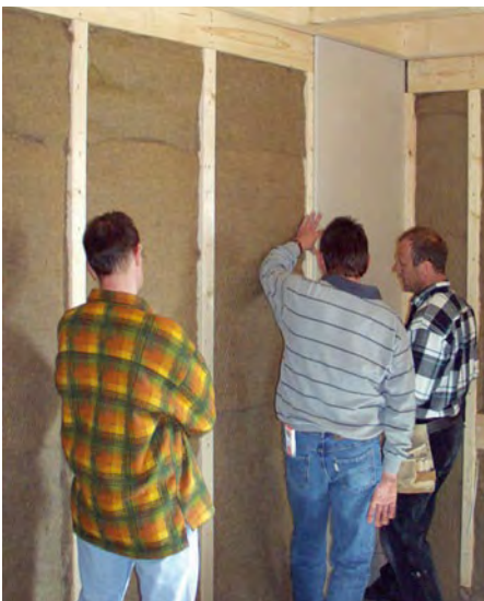
Herr Gabler zeigt auf der Ausbaus Schule, wie der Trockenbau richtig gemacht wird.
