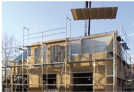
Zweiter Tag der Montage des Hauses in Forchheim: Das Dach wird geschlossen
