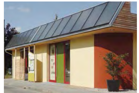
Arbeiten, wie andere wohnen dürfen: das Büro von natürlich-bauiologisch
