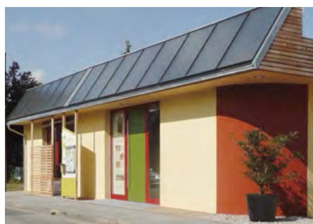
Das Sonnenhausbüro von natürlich-baubiologisch in der Feuchter Straße 19, 90530 Wendelstein
