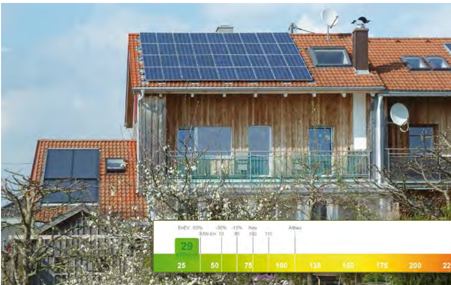
Doppelhaushälfte nach der Sanierung zum Effizienzhaus der KfW: hohe Behaglichkeit und niedrigste Energiebilanz
