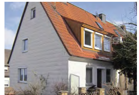
Vorher: hohe Energiekosten, wenig Fensterflächen, asbesthaltige Problemfassade
