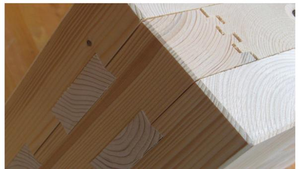
Die Massivholzwand ohne Verleimung und Metallverbinder – ein innovatives System.
