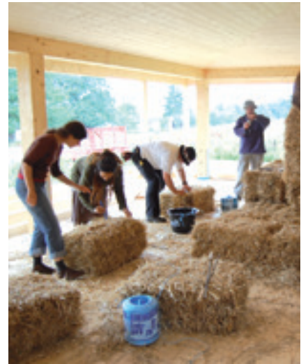
Vorbereiten der Strohballen
