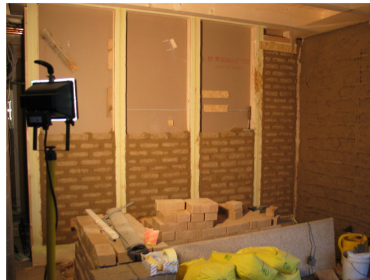
....und die Erfahrungen im eigenen Haus verwerten. Die Wohnzimmerwand gibt Speichermasse und Schallschutz mit Hilfe von lehmsteinen.
