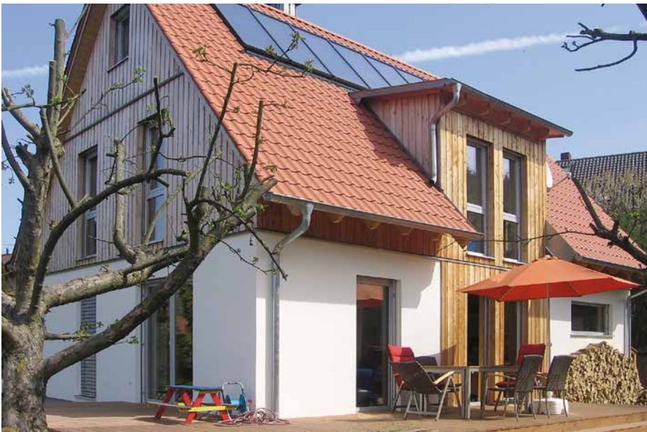
Ein Systemhaus 5 – fränkische Dachform, moderne Schleppgaube und solare Heizungsunterstützung
