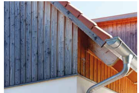
Natürliche Patina: Unbehandelte Lärchenschalung wird durch das Wetter im Lauf der Jahre grau.
